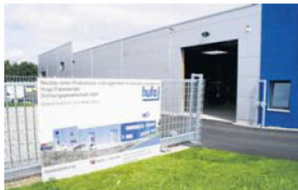
Die neue Halle hat 2 Millionen Euro gekostet. Auf 1200 Quadratmetern sind hier künftig Lager, Produktion und Verwaltung unter einem Dach.
